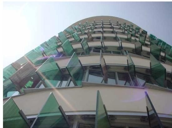
**Abbildungen 9:** Referenz außenliegende, drehbare Sonnenschutzelemente Büronutzung, PSD-Bank Karlsruhe, COLT GmbH
