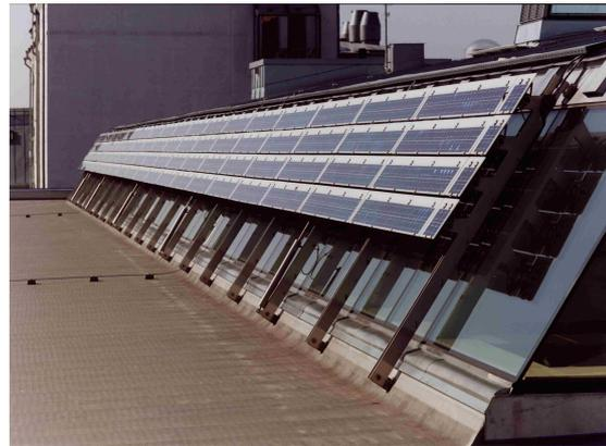
**Abbildung 11:** Referenz außenliegende, drehbare Sonnenschutzelemente Sheddach, Visby, Ausführung: COLT GmbH
